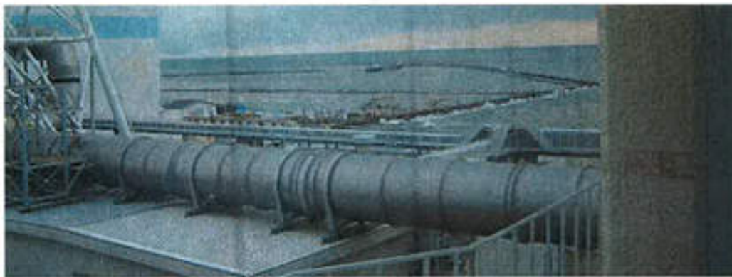
写真2. 2. 3-10 (exif情報上の撮影時刻は15時36分18秒：図2. 2. 3-5③) 東電より提供
