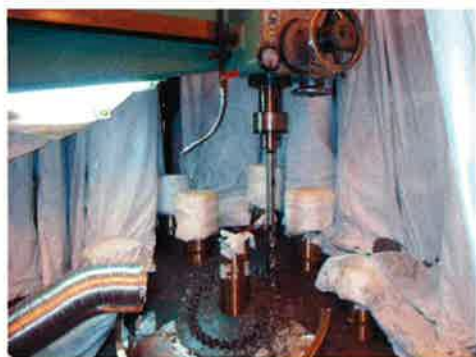
図2 管台引抜作業の様子
