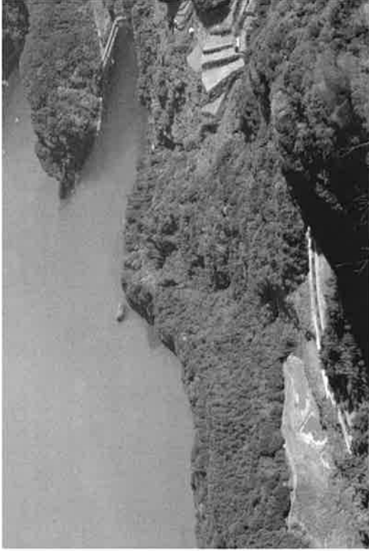
写真4 青葉山西峰頂上から俯瞰した神野浦西方海岸付近の海に流れ込んだ岩屑なだれ堆積物。
