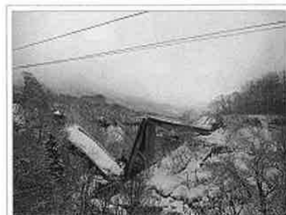
崩壊した祭時大橋
