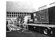
仮設電源から発電所内への電源引込み訓練（H23.3.30実施）
