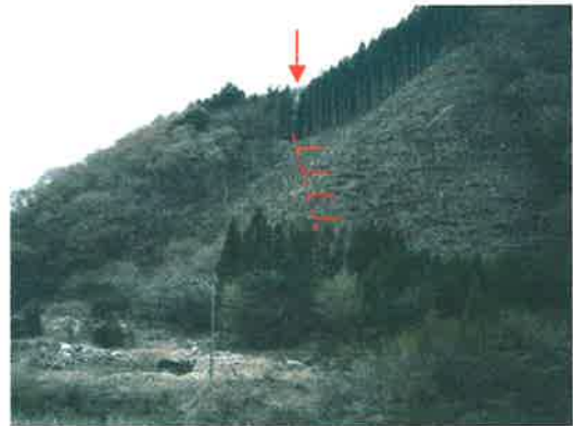
南側の対岸の斜面に、西側（写真の右側）低下の変状（写真の破線部分）が見られる。稜線部（写真の矢印の下部）で、西側（写真の右側）低下の変状が見られる。
