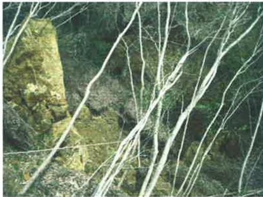
右上の写真の頂部から北側を見た写真。源頭部と見られた場所は実は崩壊したブロックであり、山体との間に 10m 以上にわたる亀裂が見える。
