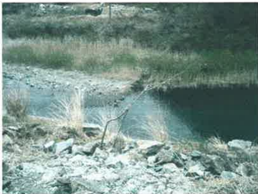
県道の南側では、鮫川河床に西側（写真の右側）低下の断層変位が出現し、上流側は水深が深くなって淵に、下流側は水深が浅くなって瀬になっている。写真は北側から撮影。
