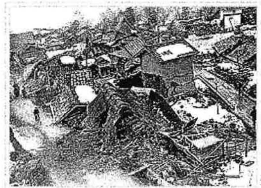
峰山町(現・京丹後市)の被害
